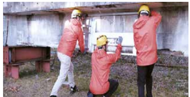
Inspection non destructive pour visualiser les fractures dans les matériaux en acier à l'intérieur d'un pont
